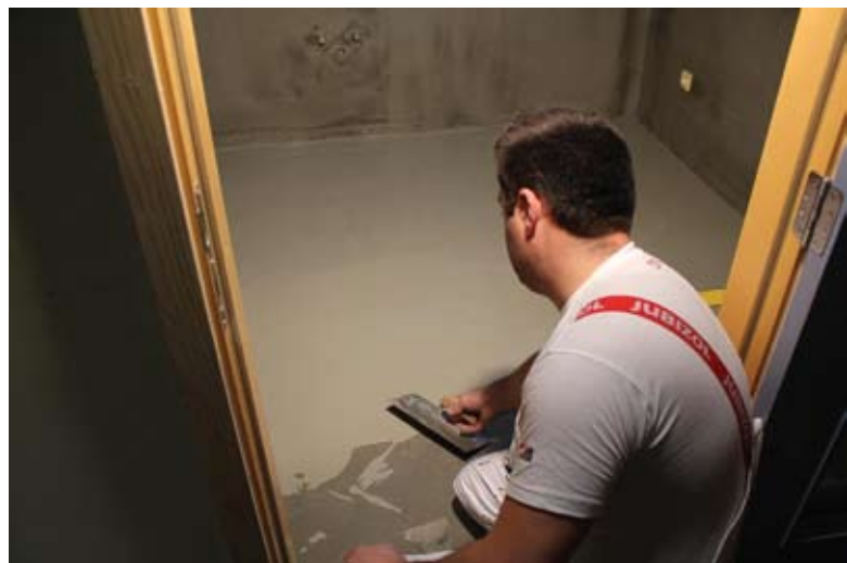
7. Нанесување на последниот 3 слој на HIDROZOL Elastik со помош на глетарка.
