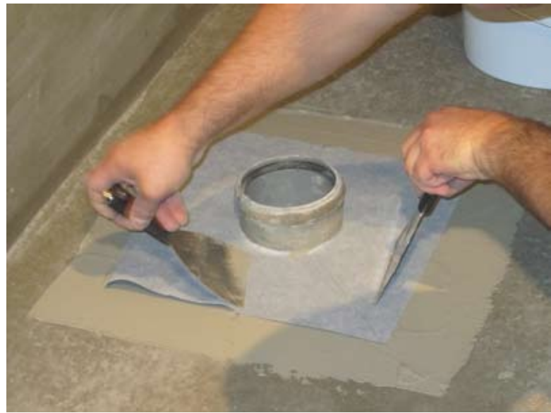
4. Повторно нанесување на HIDROZOL Elastik на хоризонталната површина со втиснување на манжетни во кои претходно се засечени отворите според величината на цевката
