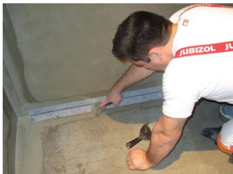
5. Втиснување на еластични ленти во слојот на HIDROZOL Elastik нанесен на под и ѕид
