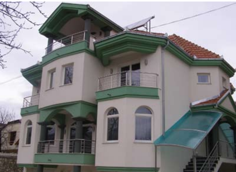
Објект: Индивидуална куќа - Битола. Jubizol стандард: ATG 1,5mm-бел, ATG 1.5mm нијанса 2401, Kulirplast 2,0mm, бр. 405
