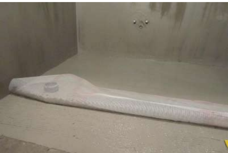
6. Втиснување на мрежата (само на хоризонтални површини) во 2 слој, кој е нанесен со помош на глетарка
