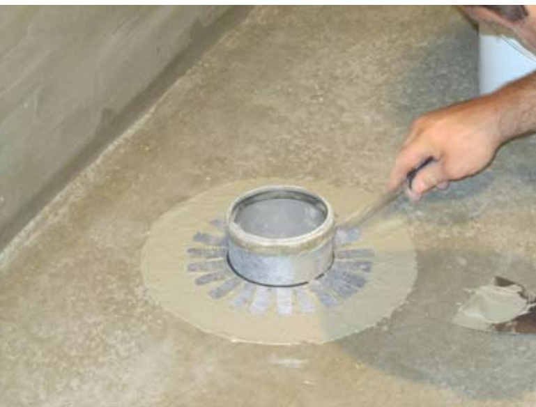
3. Втиснување на еластични ленти во сеуште свежиот нанос на хидроизолационата маса. Лентата претходно се засекува до половината, која е означена со црна линија
