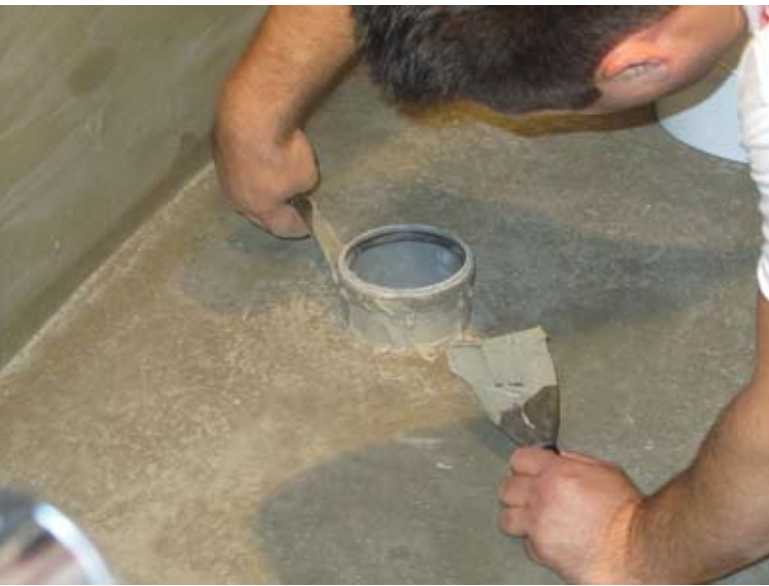
2. Нанесување на HIDROZOL Elastik со помош на молерска глетарка на претходно нанесениот 1 слој на цевката
