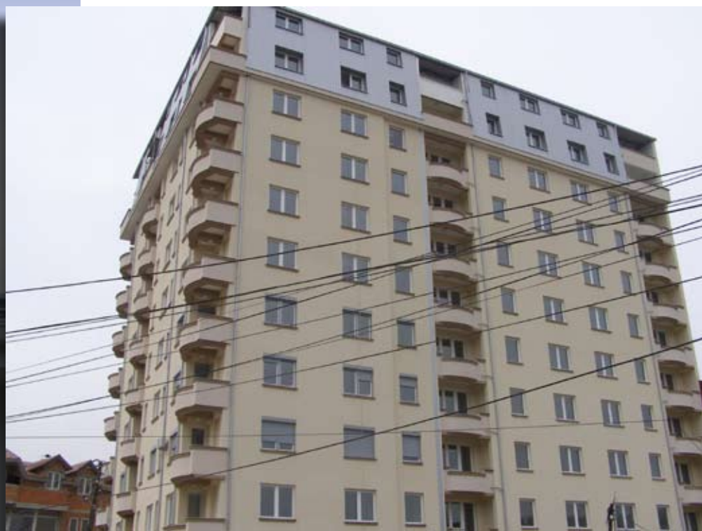
Објект населба Чаир - Скопје MAZ 2.0mm нијанси: JUB 1115 и JUB1133, ATG1.5mm нијанса JUB1132 Изведувач: Рики Бау - Скопје
