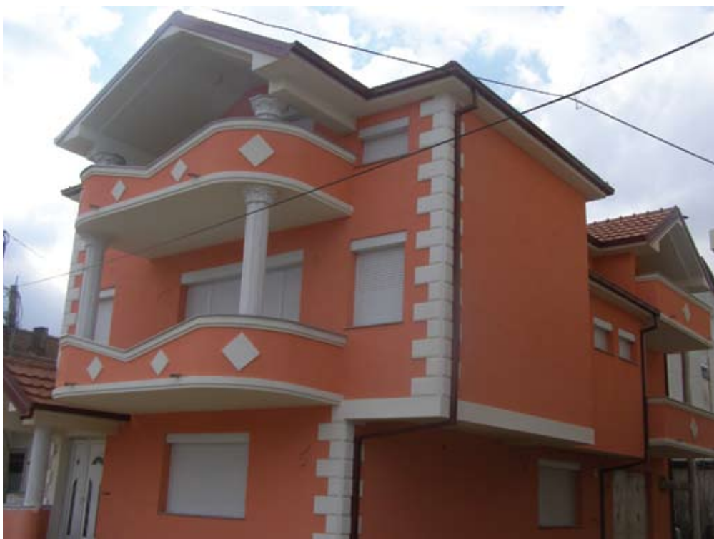
Објект Прилеп EPS LepilnaMalta, ATZ 2.0 (5572), MAG 1.5 (1001) изведувач: Ванѓелче Бебекоски - Вевчани
