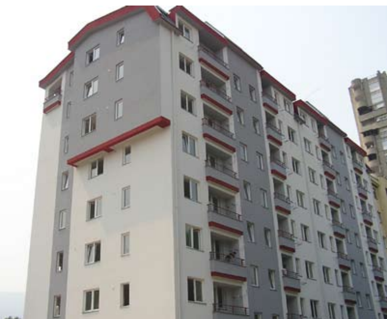
Објект: Станбена зграда – нас. Аеродром Скопје, 2012 год. MARKpro фасаден систем (MAG 1.5mm 1495,1504,1505, ACN 5581)
